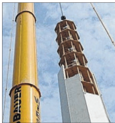
In zwei Tagen ist ein hölzernes Windkraftwerk der Timber-Tower GmbH aufgebaut. Foto: NDR
